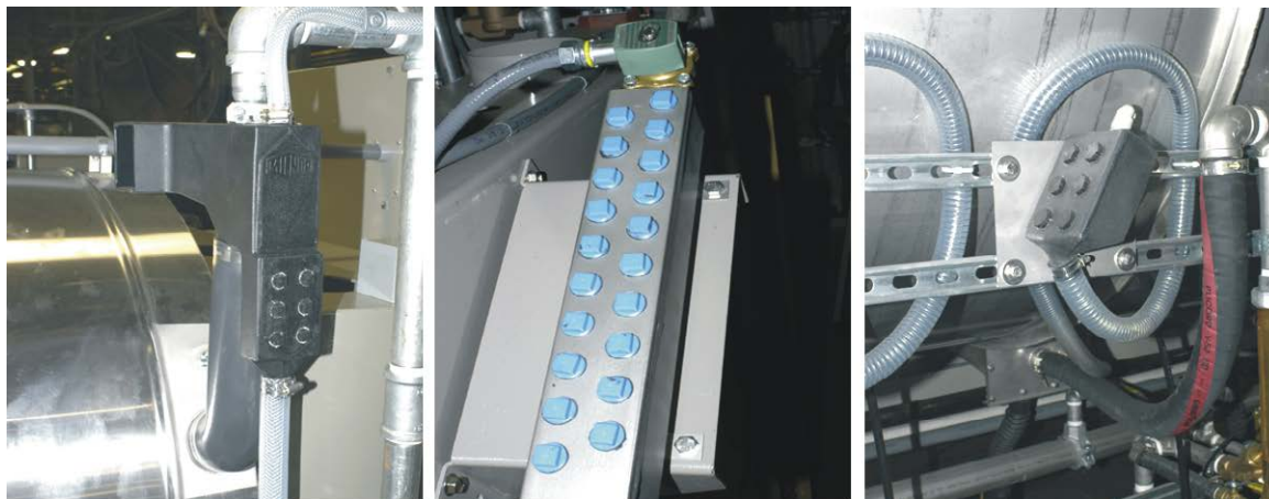
Abbildung 4: Beispiele für Sammelrohre für chemische Rohre. Ihr Zubehör könnte anders aussehen.
