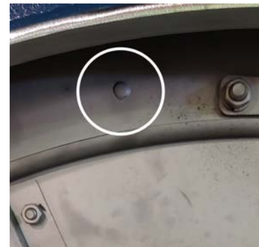
Figure 6. Point de soudure de la porte intérieure
