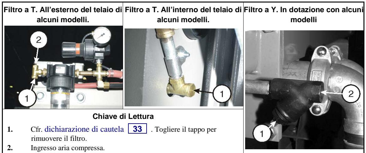
Illustrazione 17: Filtri di aria compressa in ingresso. Sono esempi. L'apparecchio può discostarsi dal modello proposto
